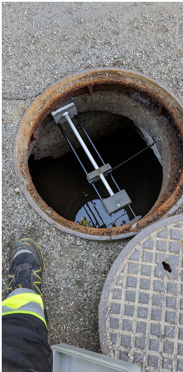
Turbinatorn på plats i en brunn.
